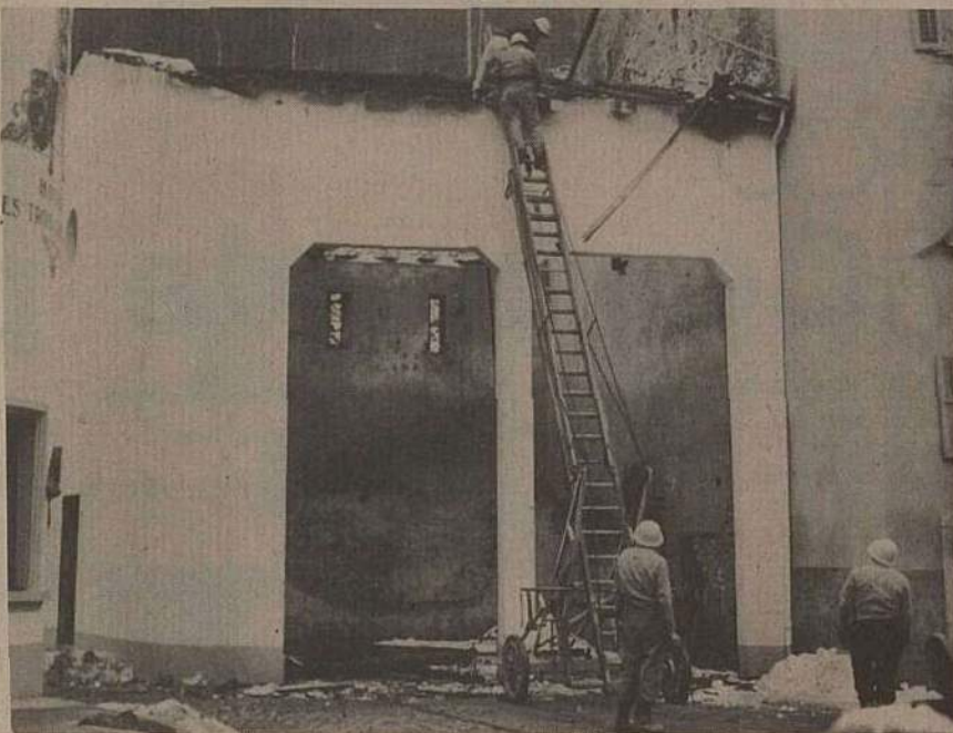
La démolition dans sa première phase.
