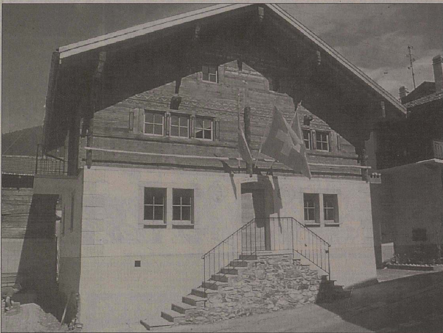
Rénovée, la Maison de Roumaz sera inaugurée officiellement dimanche dès 11 heures.
