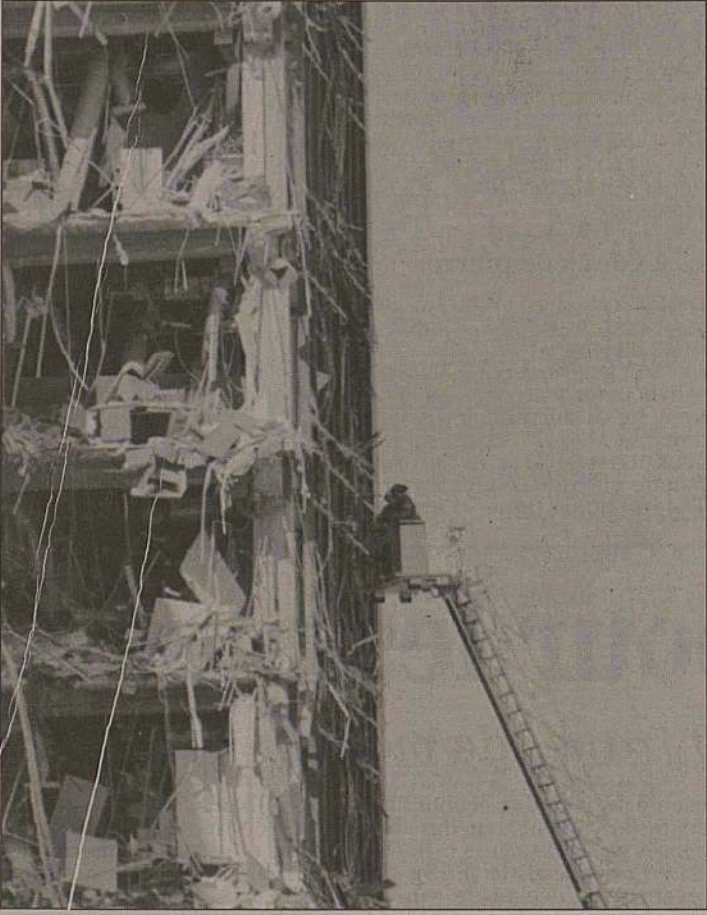
A l'aide d'élévateurs à nacelle, les sauveteurs cherchent les victimes dans le bâtiment éventré.
